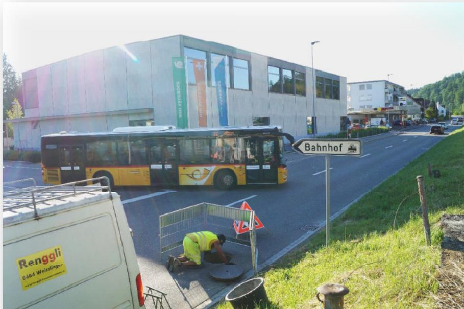
Abbildung 3: Einfache schnelle Lösung auf stark befahrener Kantonsstrasse statt aufwändigem Fahrbahnaufbruch und Verkehrsregelungen mit Ampeln
