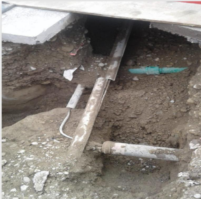
*Abbildung 1: Bestehende Situation: Neben verschiedenen Werkleitungen im Boden gestaltet sich die Positionierung eines zweiten Schachts aus Platzgründen schwierig.*
