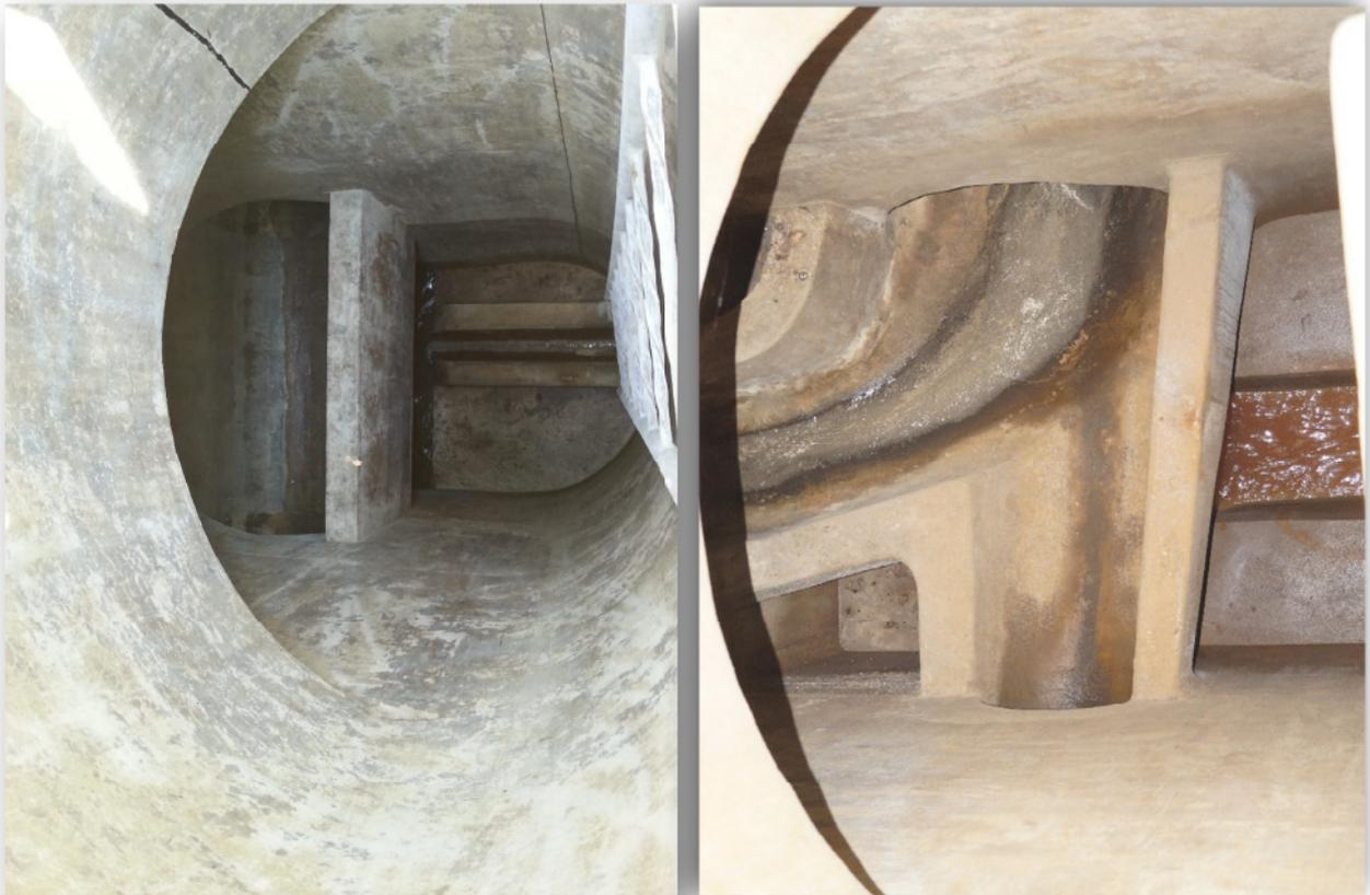
*Abbildungen 2: Zu verschliessende Meteor - Durchlaufsohlen in verschiedenen Kombischächten*
