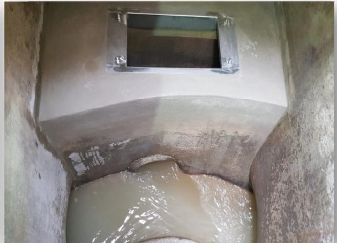
Lose Montage von Deckel und Verschlussystem Nach 20 Tagen lose Verschraubungen anziehen (Aushärtungszeit Beton)
