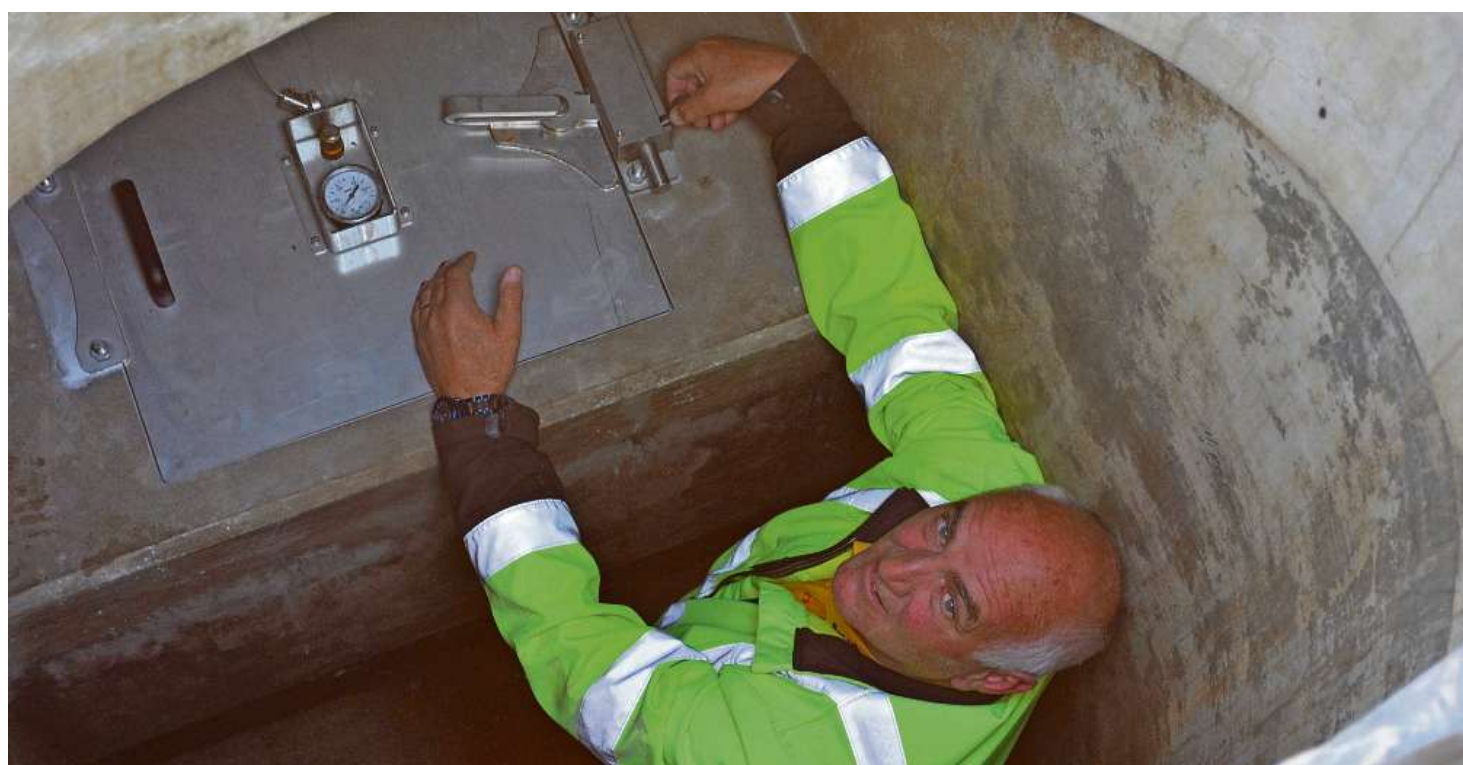
Von unten nach oben: Werner Renggli zeigt sein neues Verschlusssystem im Abwasserschacht.
