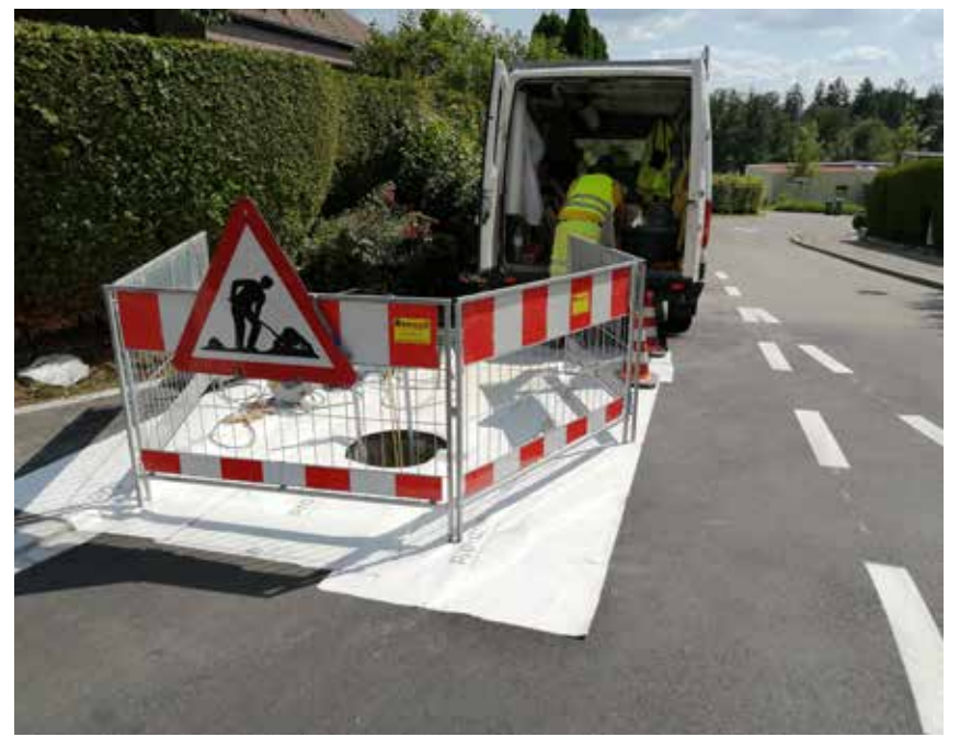
Die Vorgehensweise ist ressourcenschonend: Es werden weder Strassen aufgebrochen noch Schächte abgerissen.
